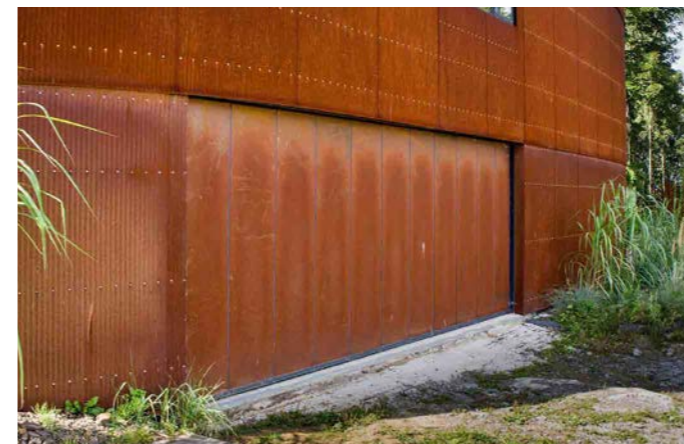
posuvná vrata s obkladem „CORTEN“ (rezavá patina)
